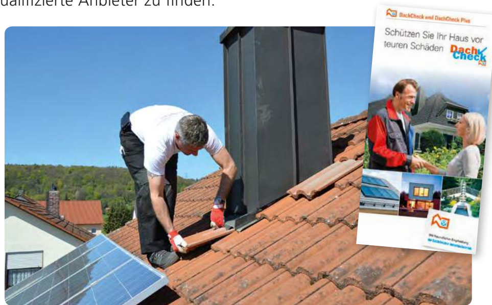
Bei der Dachwartung wird nicht nur die Dacheindeckung, sondern werden alle Dachkomponenten wie Kaminbekleidungen und Solaranlagen überprüft. Foto: Dachdecker-Verband Nordrhein
